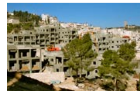
Appartamenti destinati ai cristiani in costruzione sul Monte degli Ulivi presso il Santuario di Betfage.
